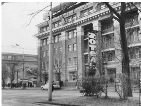
Рис. 1. Зовнішня реклама на фасаді готелю «Центральний». Дніпропетровськ, 1972. Колекція С. Головка
