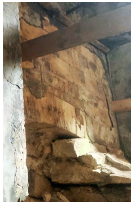
Рис. 5. Фрагмент стіни з нішею та лучковою аркою за саркофагом із тесаних блоків та залишків чорного тиньку, (фото автора 2024 р.)
