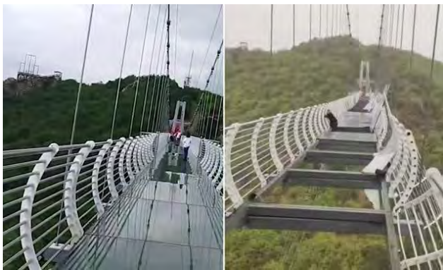
Іл. 2. Скляний міст через річку Ляньцзян у провінції Гуандун
