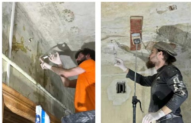
Рис. 6. Укріплення основи
