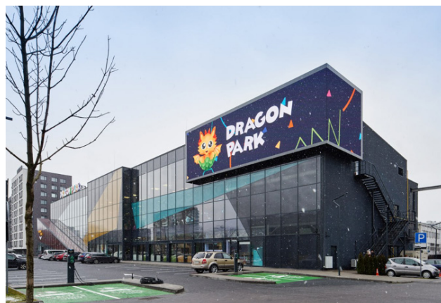
Приклад сучасного інтегрування великоформатної зовнішньої реклами у проєктування комерційної архітектури: фасад будівлі торгово-розважального центру Dragon Park у Львові. Використання скляних поверхонь, інтеграція фірмового стилю та зоноване розміщення рекламних площ забезпечують візуальну чистоту і відповідність сучасним тенденціям оформлення міського середовища. Фото (pragmatika.media)
