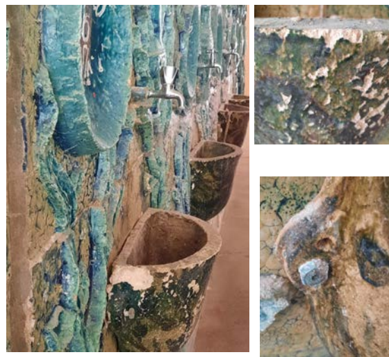
Рис. 2. Приклади пошкоджень керамічного панно-бювет мінеральних вод у санаторії «Моршин-Прикордонник» фото автора
