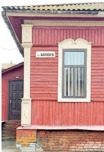
Рис. 8. Образ ніжинського будинку зі скругленими подвійними дужками карнизу над ошатною лиштвою, кутовими пілястрами, прикрашеними фільонками з ромбами, слізником з рядами орнаментальної різьби із мотивом сердечника. Межа кінця ХІХ – початку ХХ ст. Фото А. Постола
