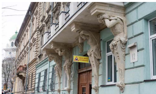
Рис. 2. Балкон на вул. Листопадового Чину, 12 у м. Львів, Стан після реставрації, 2015 р.
